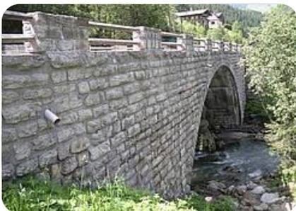
Beide Brücken sind steingemauerte Bogenbrücken mit lichten Weiten von 17,4 bzw. 24,0 m und wurden im Jahre 1934 erbaut. Die derzeitige Fahrbahnbreite beträgt 5,50 m. Als seitliche Absturzsicherung dienen ebenfalls steingemauerte Pfeiler, die mit Holzplanken verbunden sind.
